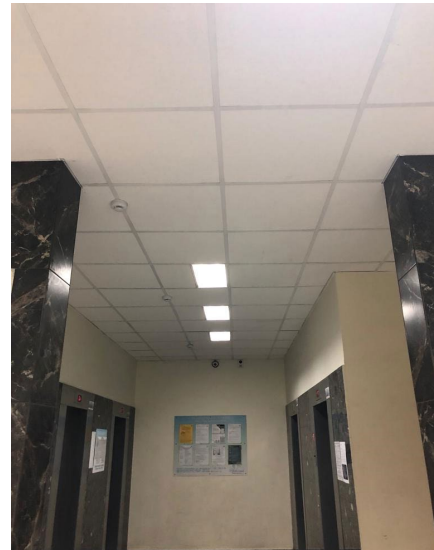
8) 23.05.23 На 1-м этаже устранение провисания потолочной плитки
